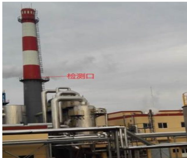
硫磺制酸尾气处理措施及排气筒
